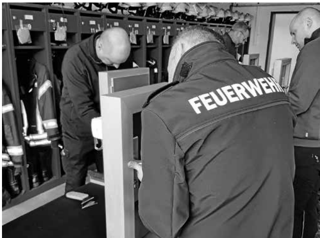
Zerstörungsfreies Öffnen von Fenstern
