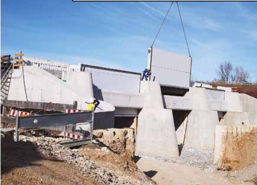
Der Bau des 'Hochwasserrückhalteraums IV' zwischen Plüderhausen und Urbach durch den Wasserverband Rems schreitet gut voran. Mit dem Einsetzen der Schütztafeln am entstehenden Durchlassbauwerk schafften die Arbeiter am Dienstag einen weiteren Meilenstein des gut 17 Mio. € teuren Großprojekts.
