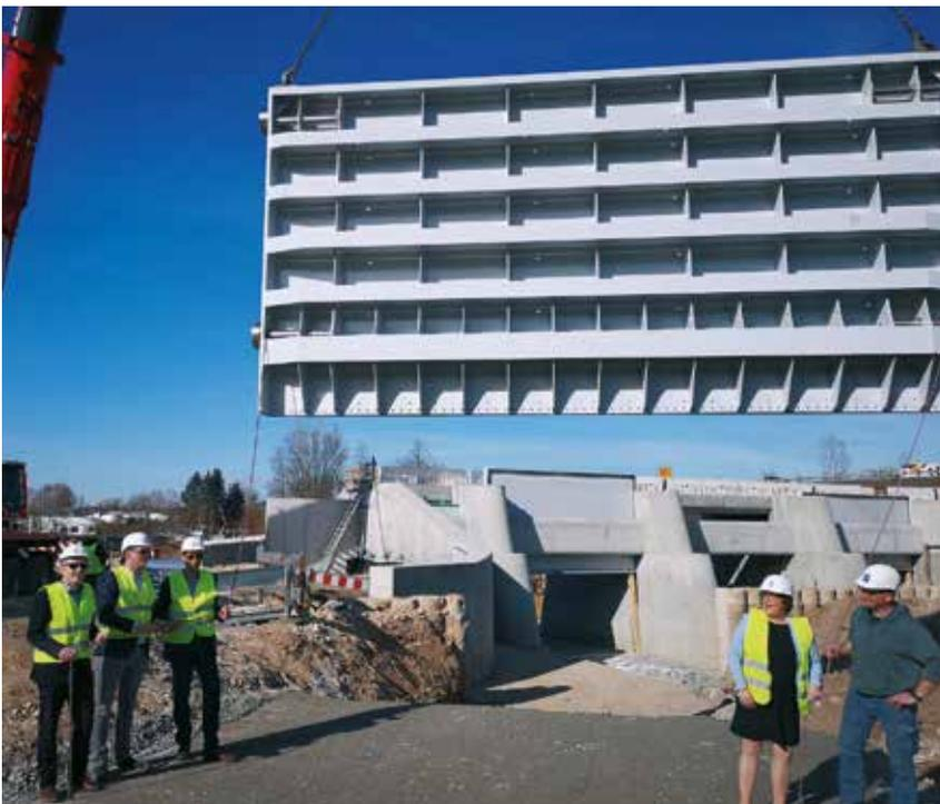
Die absenkbaren Tore verlangsamen bei Hochwasser die Fließgeschwindigkeit der Rems und speichern einen Teil des Wassers im rund 665.000 Kubikmeter fassenden Becken zwischen.
