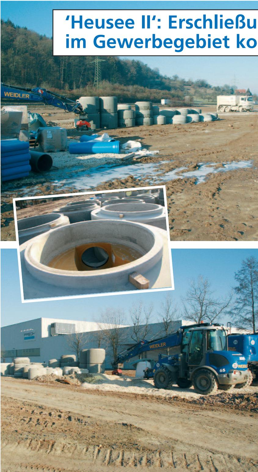
Die Bauunternehmung Weidler aus Urbach hat in den letzten Wochen im Bereich des Oskar-Frech-Platzes die Anschlüsse des geplanten Gewerbegebietes 'Heusee II' an das Wasserleitungsnetz und an das Gasversorgungsnetz vorbereitet. Auch mit der Verlegung der Regenwasser- und Mischwasserkanalisation wurde begonnen. Für die Fortführung dieser Arbeiten sind schon zahlreiche Betonfertigteile für Schachtbauwerke auf der Baustelle verfügbar.
