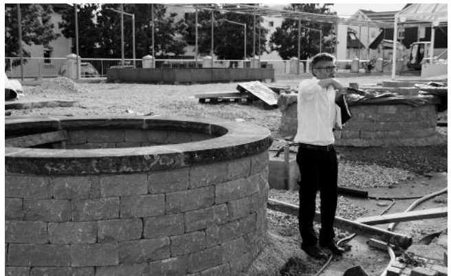
BM Schaffer auf der Baustelle am Marktplatz.
