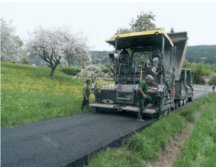
*Teilweise mussten die Arbeiter den alten Bestand zunächst profilieren – sprich den Untergrund einebnen – bevor sie die neue, 8 cm dicke, Asphaltsschicht aufbringen konnten.*
