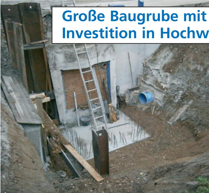
In der Remsstraße entsteht derzeit ein Schachtbauwerk mit Schlüssel-funktion: es regelt die Regenwasserentlastung in die Rems und die Überleitung bei Hochwasser in die Hochwasserpumpstation Linthal-denweg. Die Trennung zwischen dem Abwasserabfluss zur Kläranlage und der Regenentlastung kann hier elektronisch überwacht und gesteuert werden.
