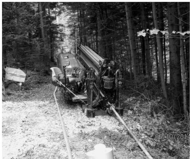
Mit moderner Technik treibt die NetCom BW den Anschluss von Walkersbach an die Glasfaser-Haupttrasse, die beim Haghof verläuft voran. Auf dem Bild eine Maschine zur grabenlosen Verlegung der Leerrohre für die Glasfasern. Die Technik wird auf den Abschnitten der Zuleitungstrasse eingesetzt, auf denen es langwierig und schwierig ist, Baggerarbeiten durchzuführen. Mitte November soll die neue Technologie mit finanzieller Unterstützung des Landes und der Gemeinde in Walkersbach verfügbar sein.
