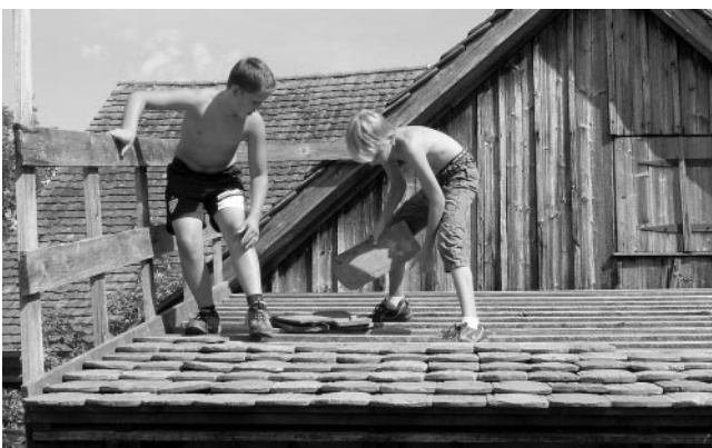
Historische Techniken des Hausbaus - Eindecken eines Daches mit Bieberschwänzen.
