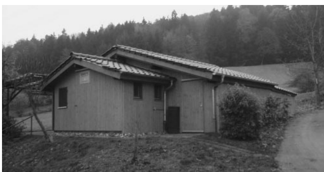
... das neue Dach glänzt in der Novembersonne.
