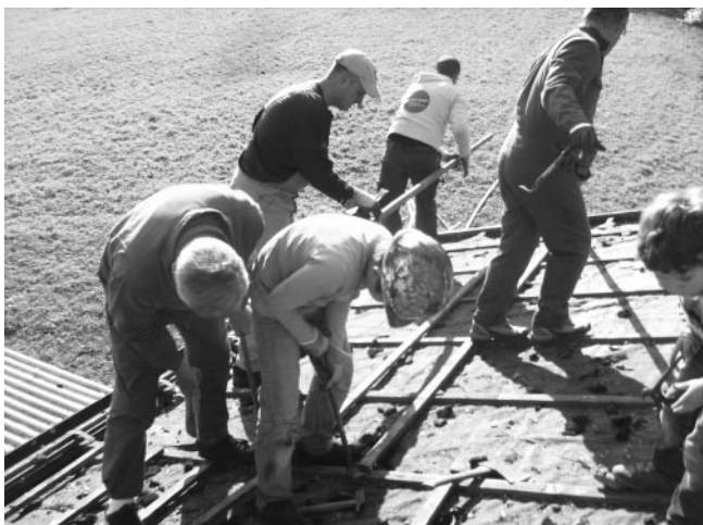
Das alte Dach verschwindet .....
