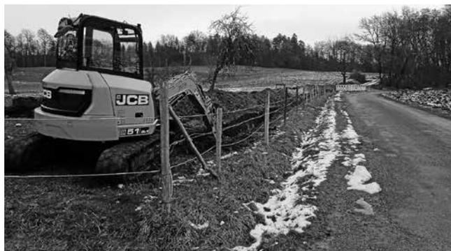
In der letzten Woche haben die Arbeiten zur Trinkwasserleitung im Plüderwiesenhof begonnen. Im ersten Teilstück wurde die Wasserleitung verlegt. Wenn es die Witterung zulässt wird im Januar noch ein Schachtbauwerk gesetzt und die Wasserleitung angeschlossen. Somit wäre eine dauerhafte und witterungsunabhängige Wasserversorgung mit Trinkwasser gewährleistet.
