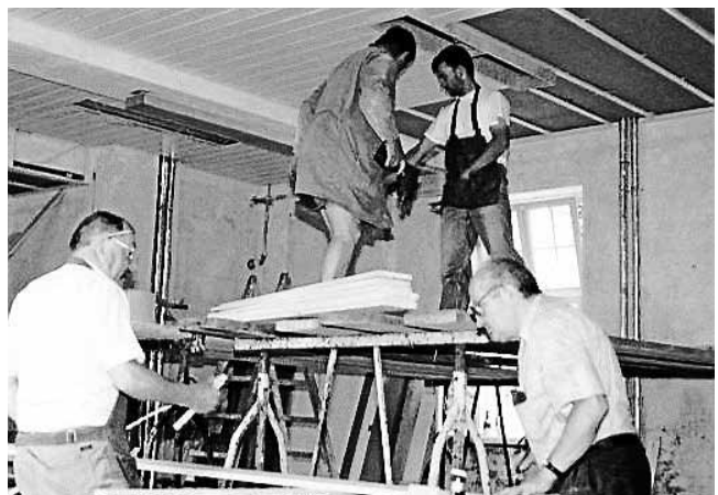
Zeitzeugen-Foto: Bei der Renovierung Anno 1995
