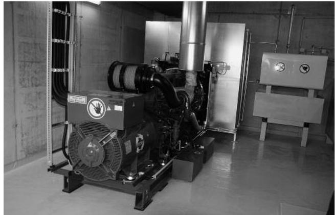
Ein Notstromaggregat mit einem 600-PS-Motor wird für den Fall eines Stromausfalls vorgehalten
