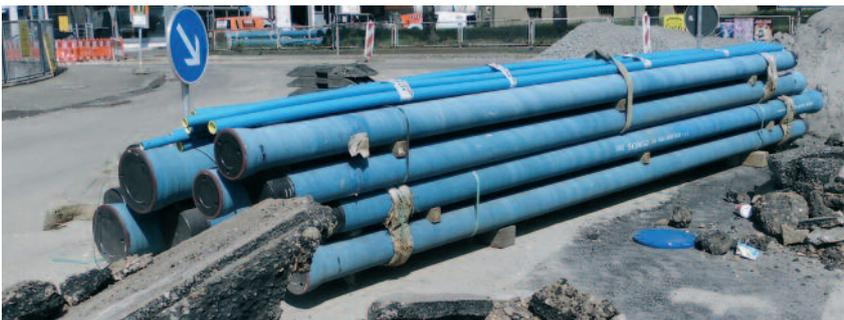
Dieser Abschnitt gehört zu einer den Ort umlaufenden Ringleitung. Dieser Ring sorgt für einen gleichmäßigen Wasserzulauf in die verzweigten Verteileranlagen in den Straßenzügen. Die Firma HSE aus Kernen im Remstal hat sich nach einer Ausschreibung dieser Baumaßnahme angenommen. Mit diesem rd. 260.000 € teuren Neubau konnten ca. 0,4 % aller Hauptleitungen ausgewechselt werden.
