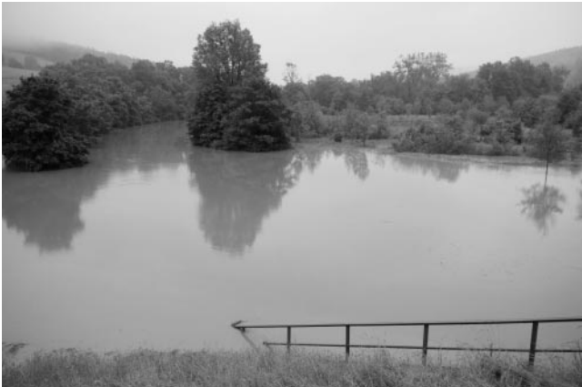
Geflutetes Rückhaltebecken am Freitagnachmittag
