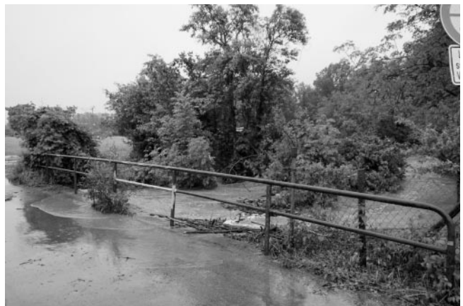
Die Bärenbachbrücke im Rank am Freitagvormittag
