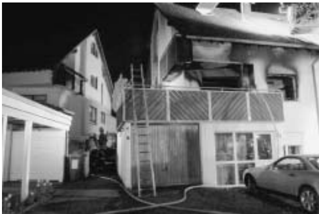
Vollständig ausgebrannte Wohnung im 1. Obergeschoss
