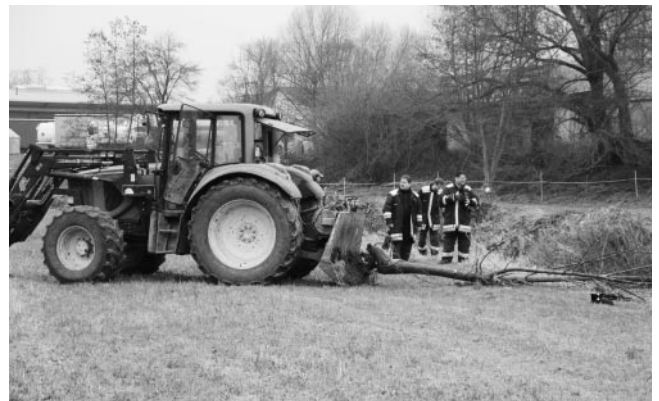
Einsatz von schwerem Gerät am Uferbereich.
