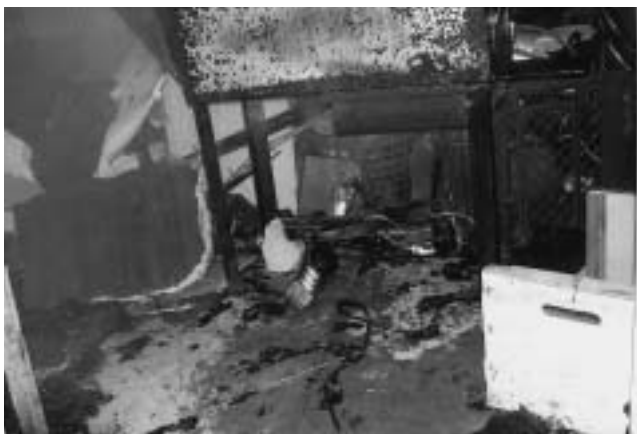
Angebrannte Inneneinrichtung im Bauwagen
